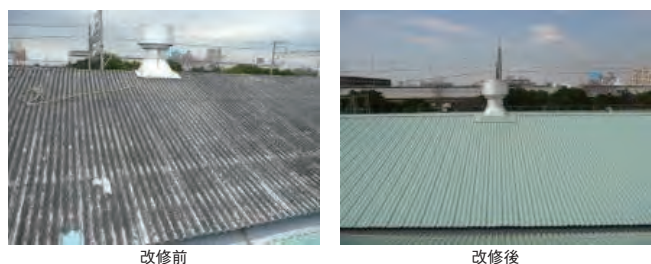
写真1 スレート屋根の改修
