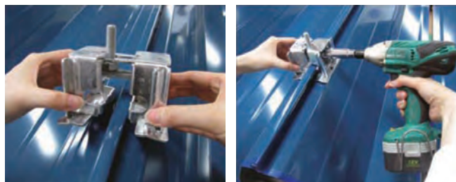
写真5 折板へのPVパネル固定用金具 7)
