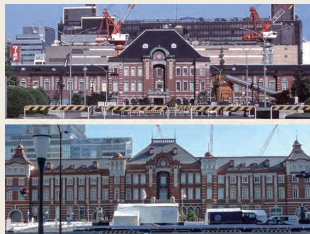
図4 東京駅丸の内駅舎(上:1994年,下:2012年)
