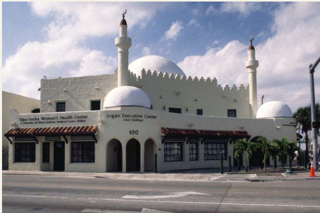
図3 ハリー・ハートビルディング 市庁舎と共に町のランドマークとなっている建物。 アリバ通りとオパラッカ大通りの角に立つ。
