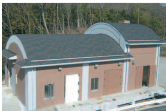
（豊田市 第二京ヶ峰配水場事務所）
