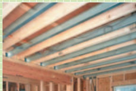
鋼製吊天井根太
