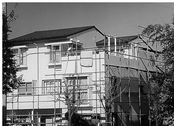
仮設に費用がかかる屋根のリフォーム
