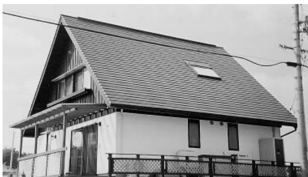
カラー折板(ブラック)葺き屋根
