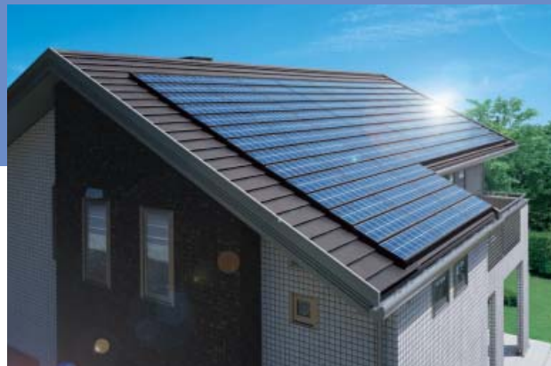
ソーラー発電システム
