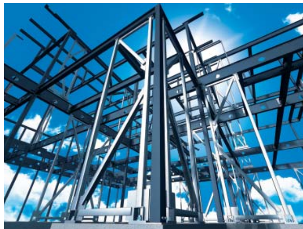
柱・梁ラーメン構造
