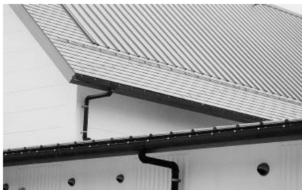
クリニック住宅の横葺きと縦葺きの屋根
