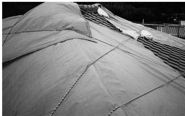
ビニールシートでの雨漏り防止
