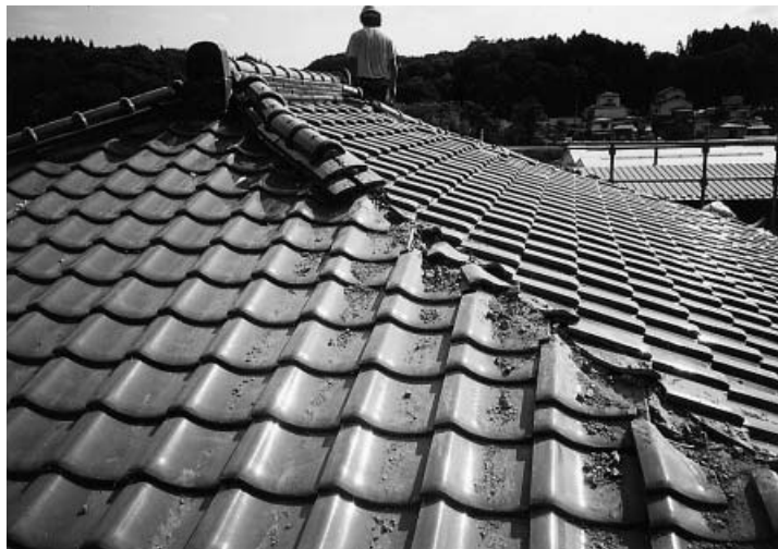
地震による瓦屋根の損傷
