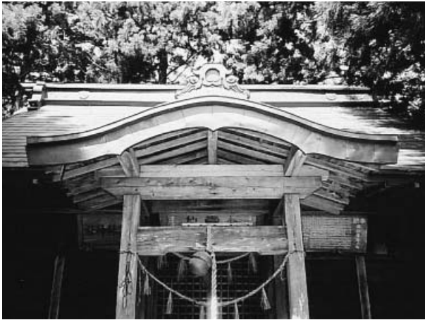
写真3 向拝（唐破風は見え掛かりのみの装飾）
