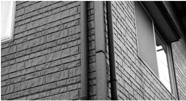
農村の中に建つ中古住宅で、かつてはカラータタン製角波を貼ってあったものを、タイル調プレス外壁でリフォームした。
