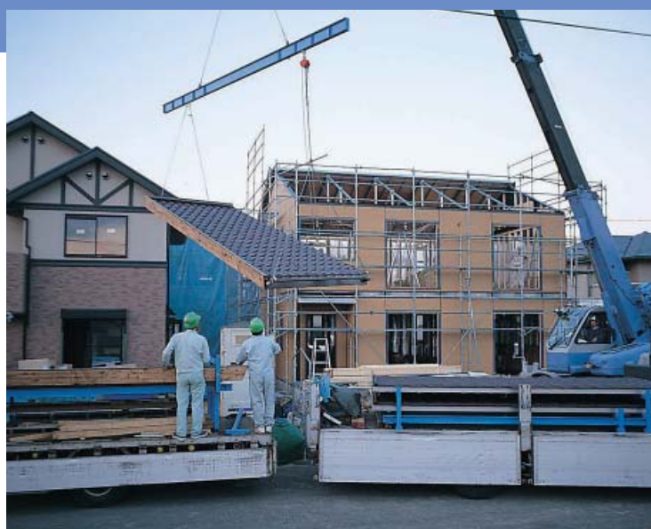
大型屋根パネルの工法による屋根工事
