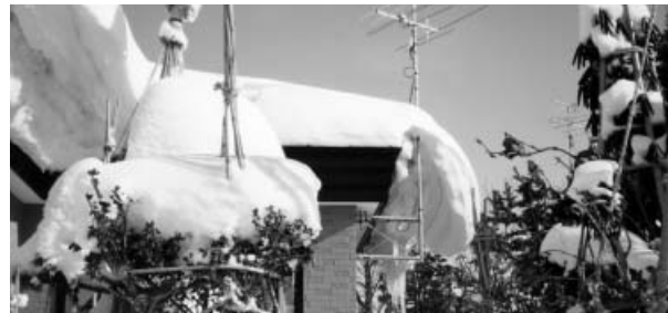
写真 住宅の屋根の巻きだれ
