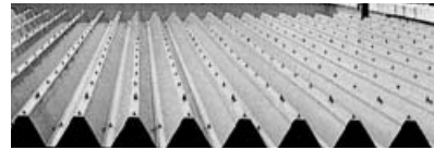
折版構造の屋根 (三晃金属工業提供)
