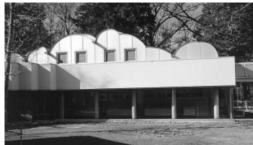
着色亜鉛鉄板葺き屋根の田崎美術館 B棟資料室外観 (田崎美術館提供)
