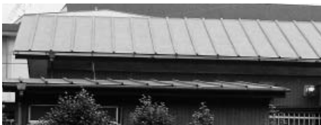
長尺板を使用した屋根
