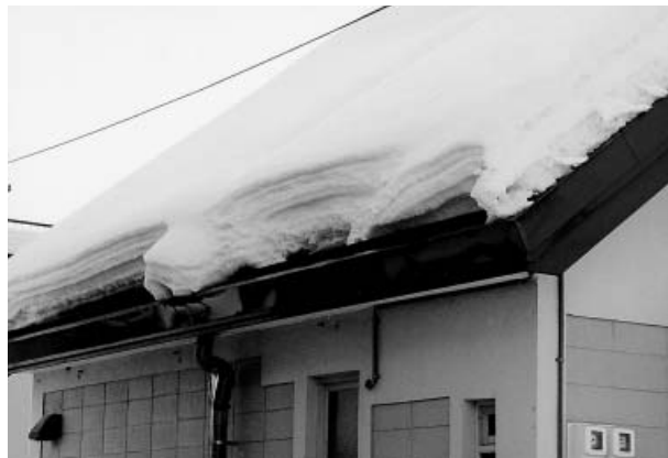
屋根からの落雪でトラブルが続発
