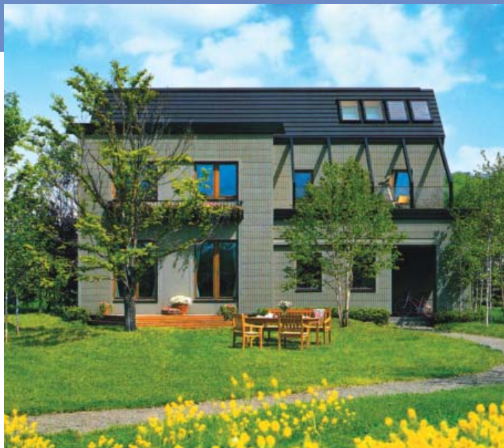
寒冷地における性能実験棟
