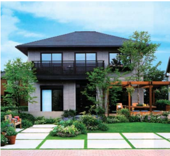
寄棟の2階建住宅
